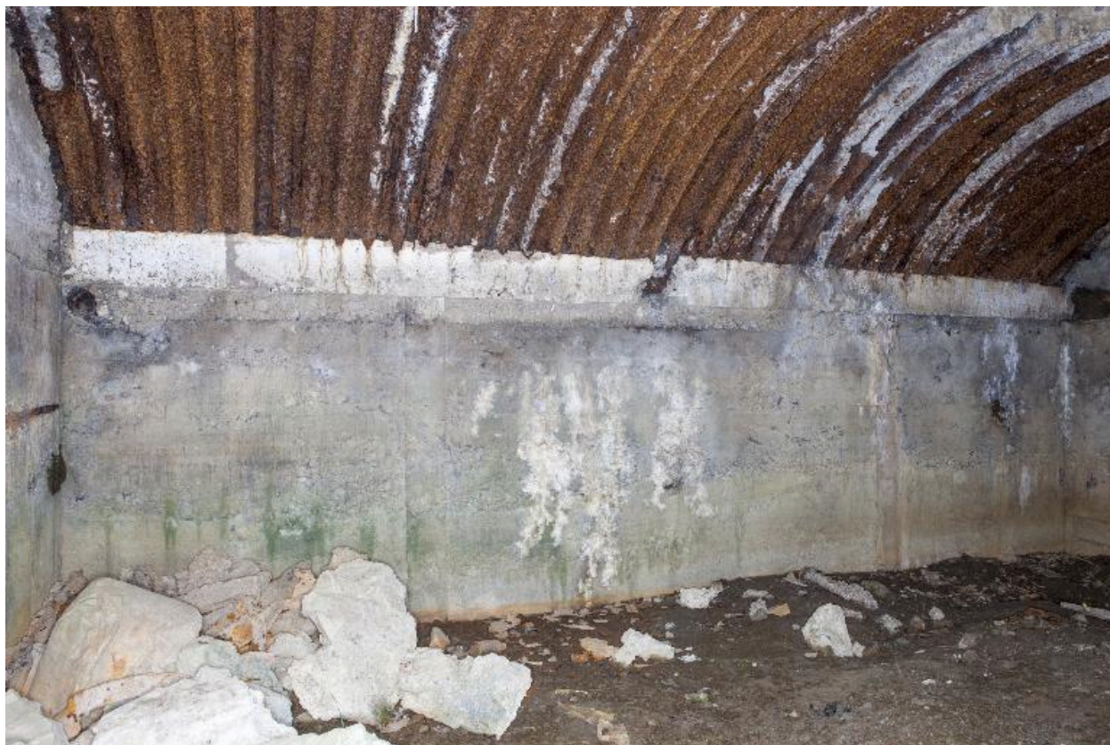
Vue intérieure, mur nord-ouest
