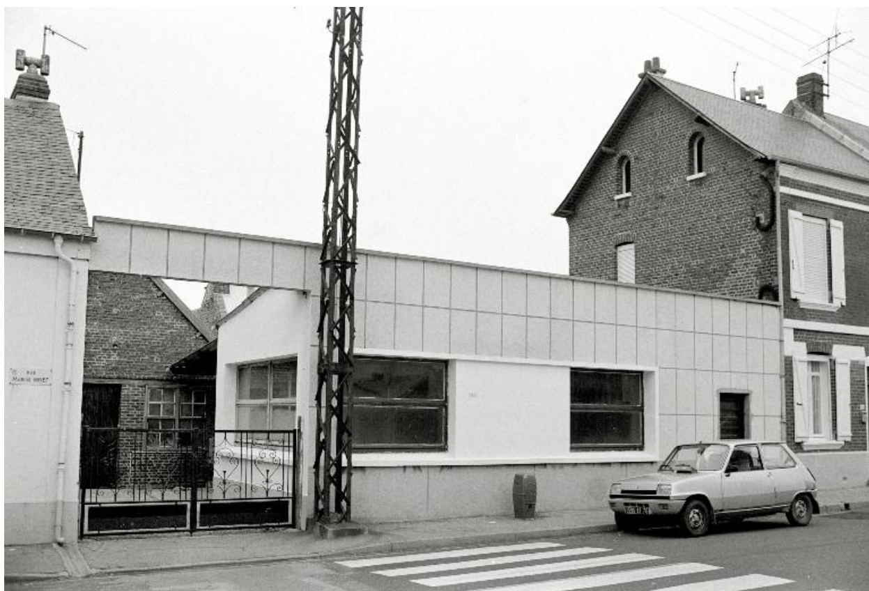
Vue depuis la rue de l'atelier et des anciens bureaux de l'ancienne fonderie Gagny et Fils.
