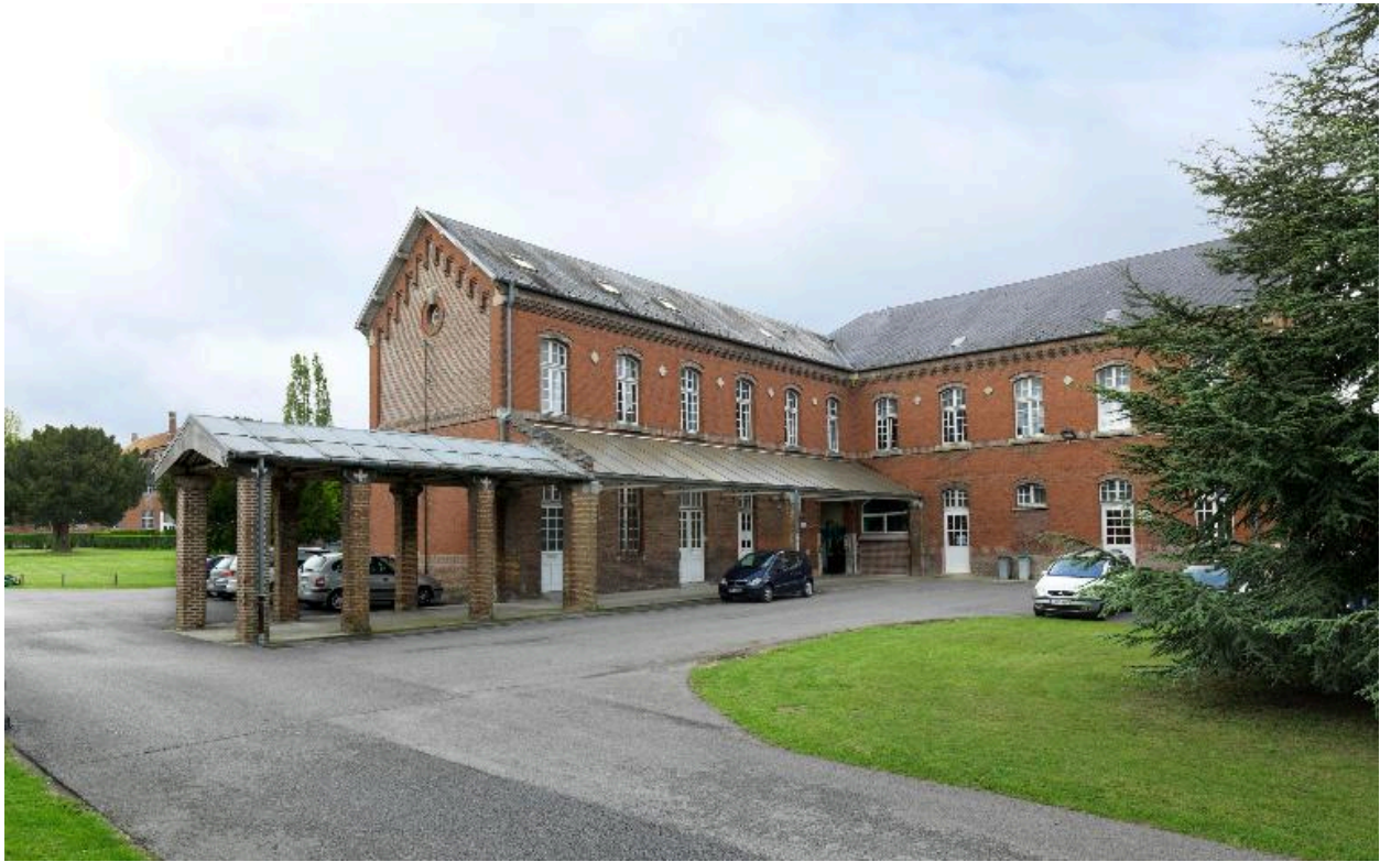
L'ancien bâtiment des cuisines et des réfectoires. Vue depuis l'ouest.
