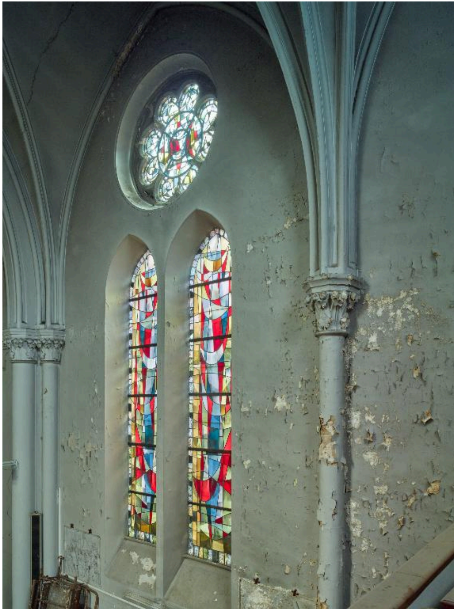
verrière de la nef, côté nord
