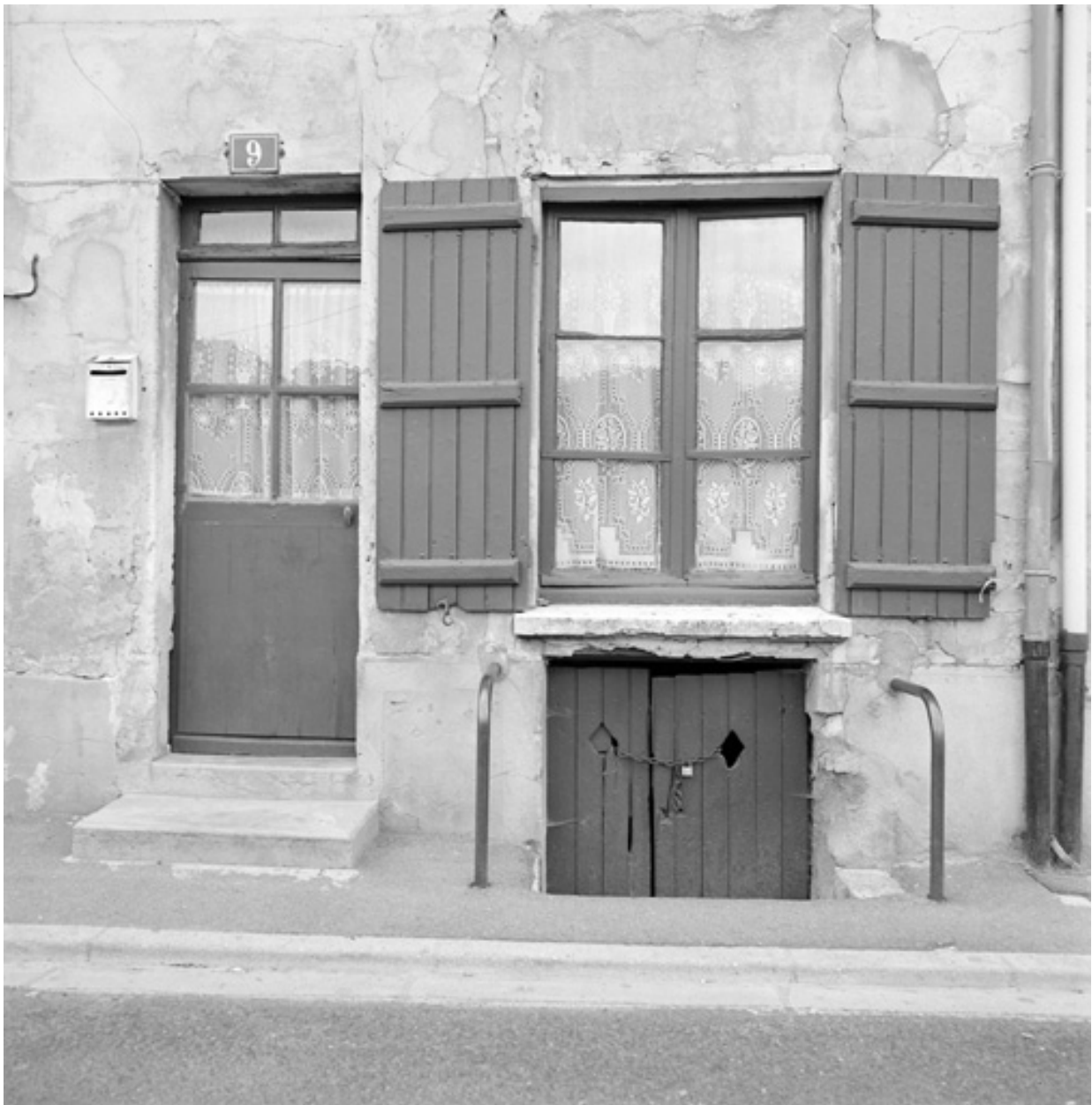
Détail de la façade : l'entrée de la cave.
