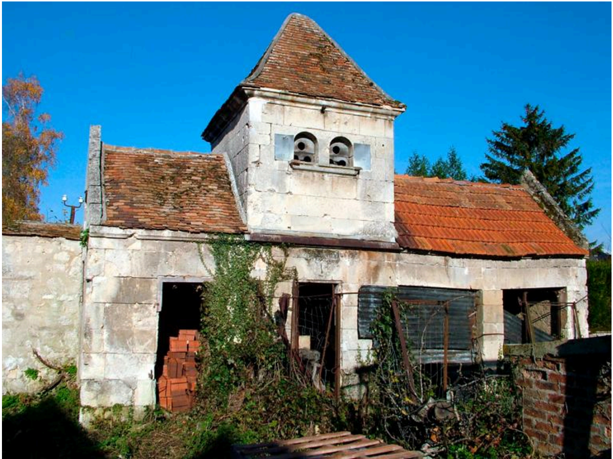
Vue des communs du logis abbatial.
