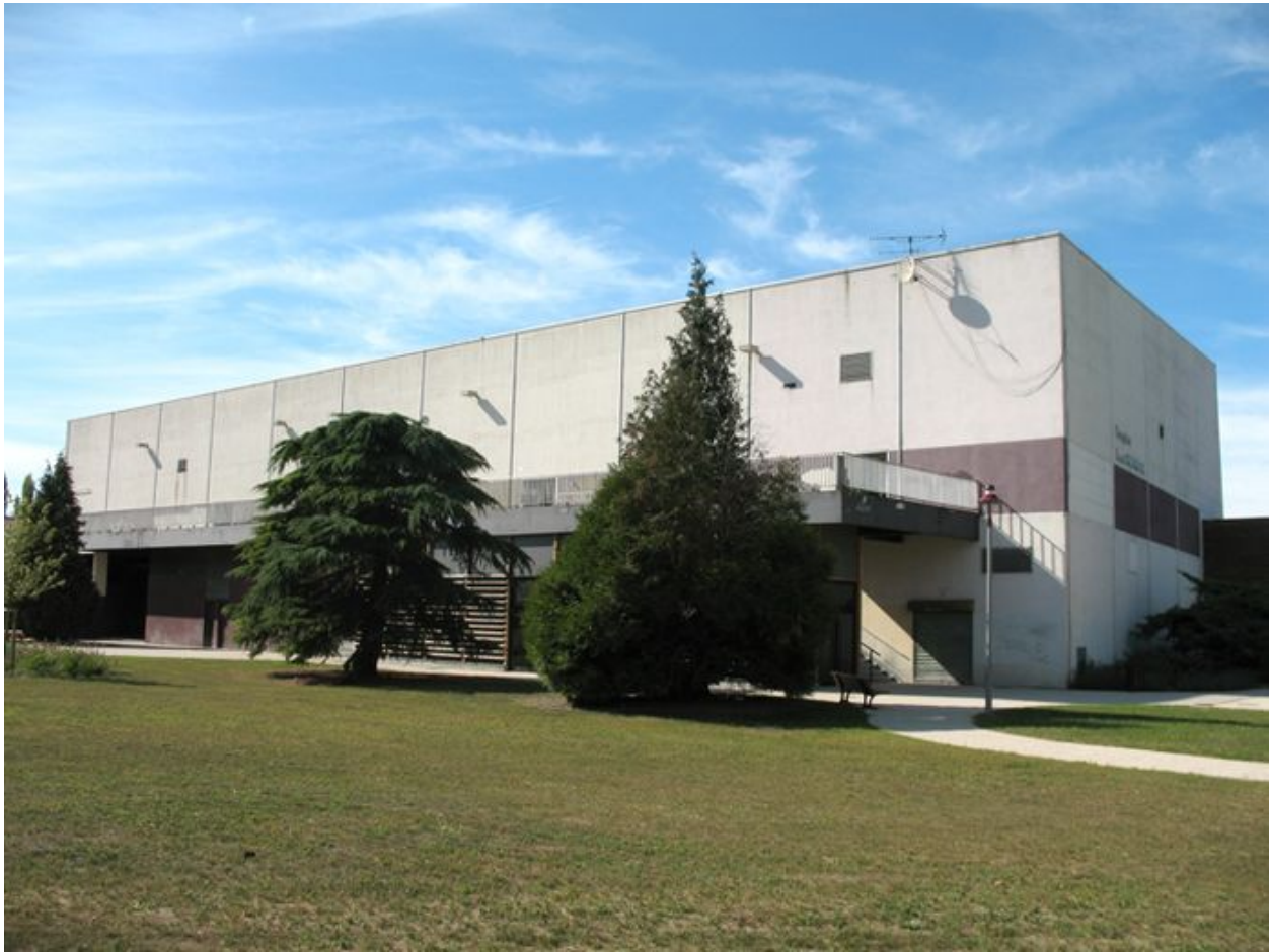
Façade ouest du gymnase.
