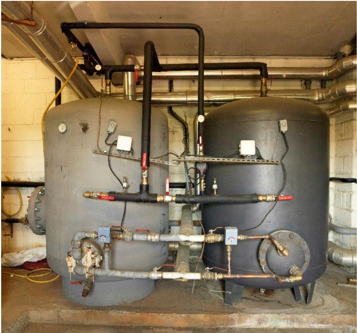
Chaufferie : chauffe-eaux.
