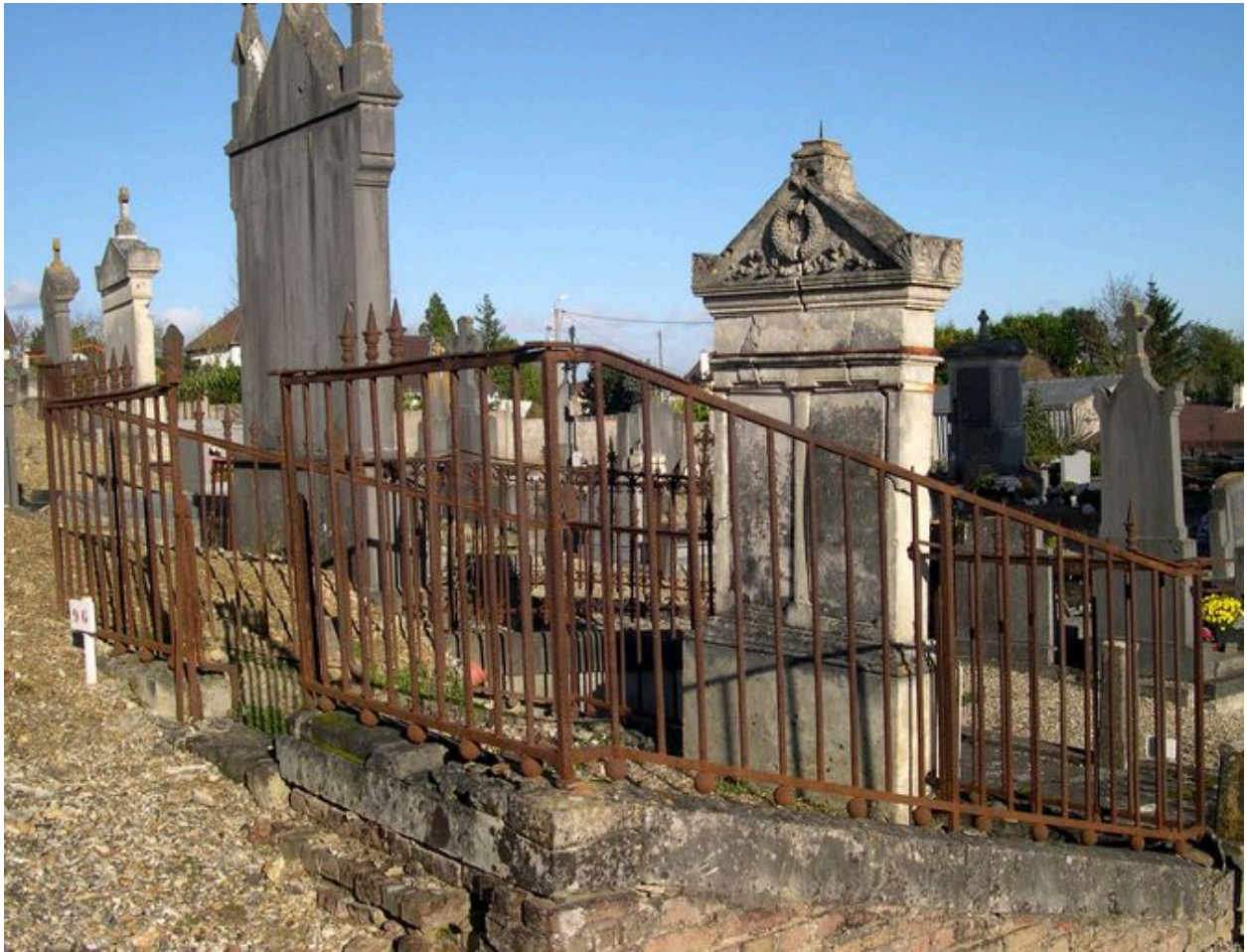
Vue générale depuis le sud-ouest.
