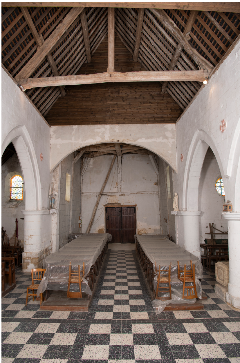
Vue intérieure vers la nef.
