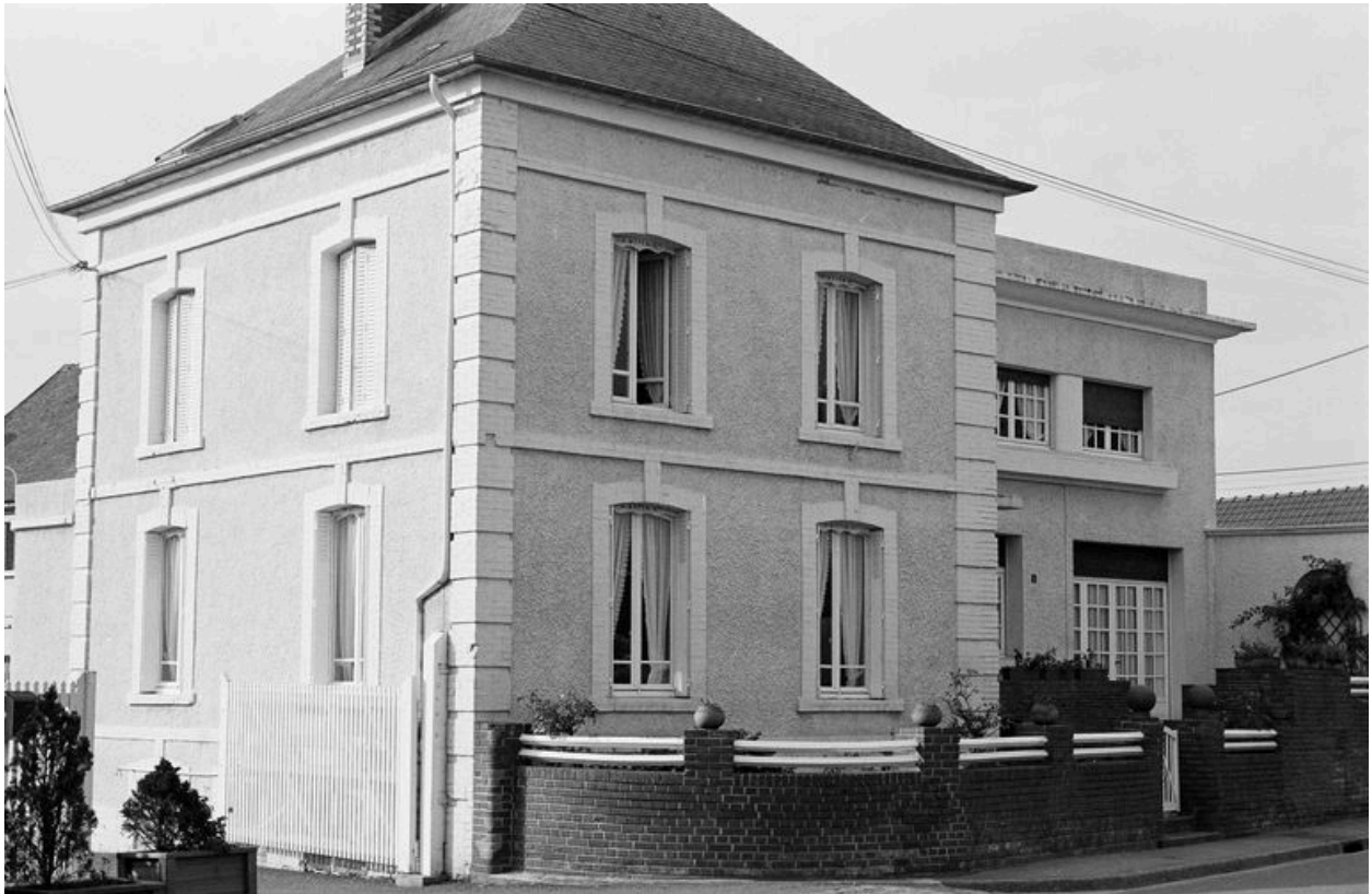
Logement patronal : façade sur rue.
