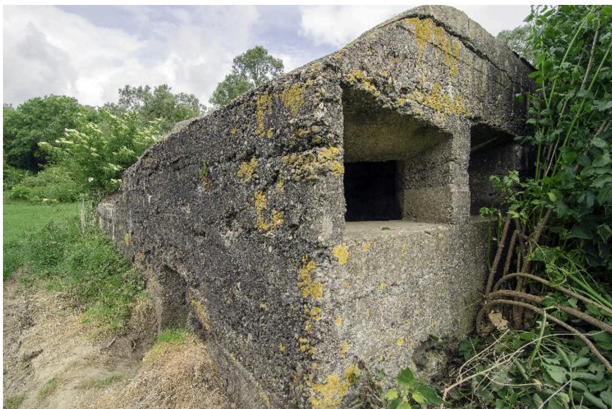
Vue générale vers nord
