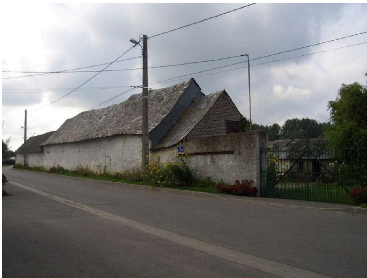
Vue des bâtiments sur rue depuis l'est.
