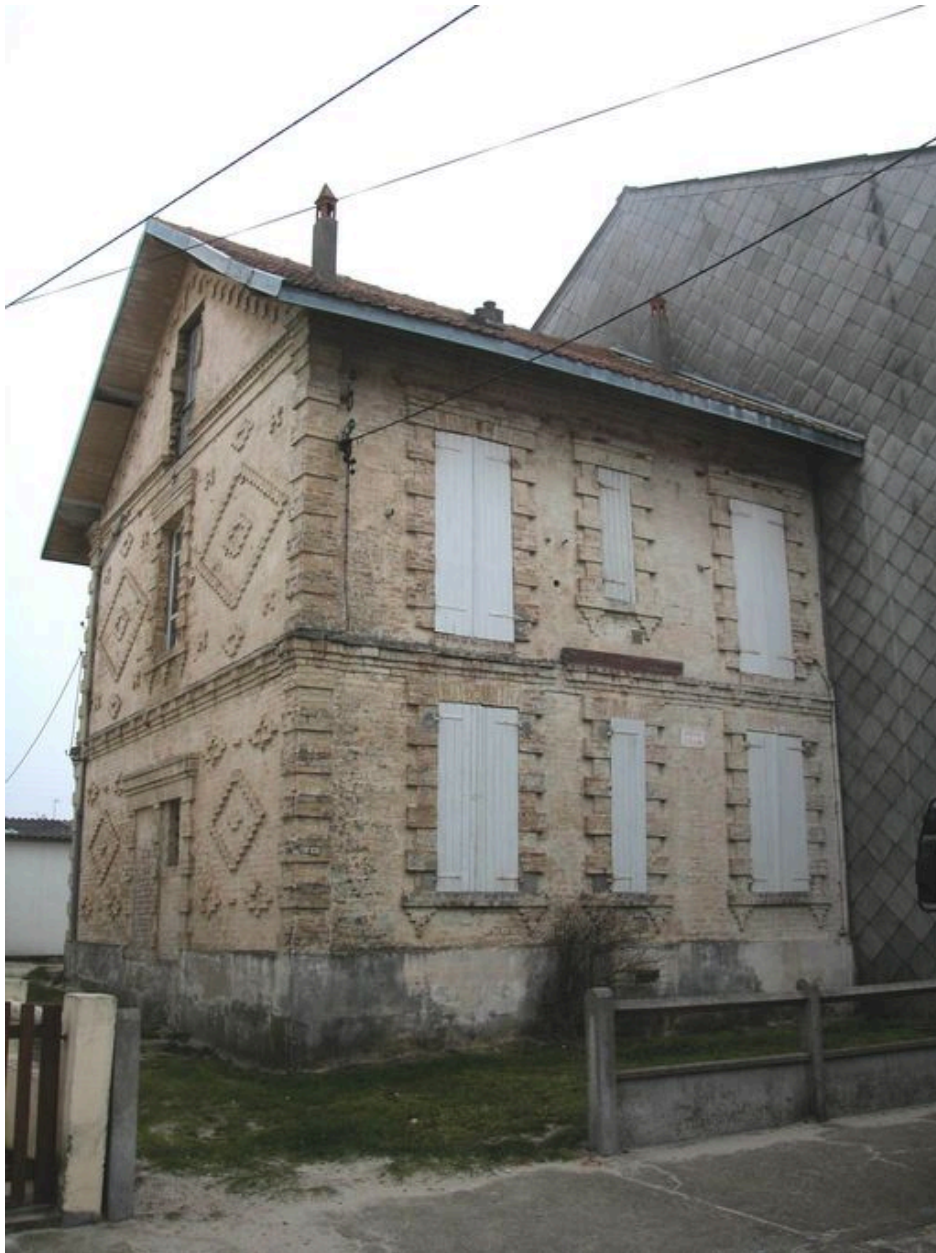
Vue d'ensemble de la maison dite Guy Jean-Claude, la moins dénaturée.
