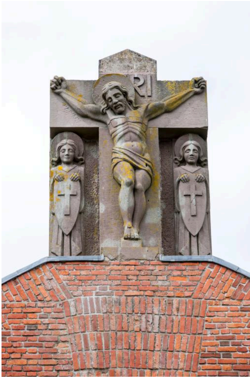
Pignon sud. Christ en amortissement.
