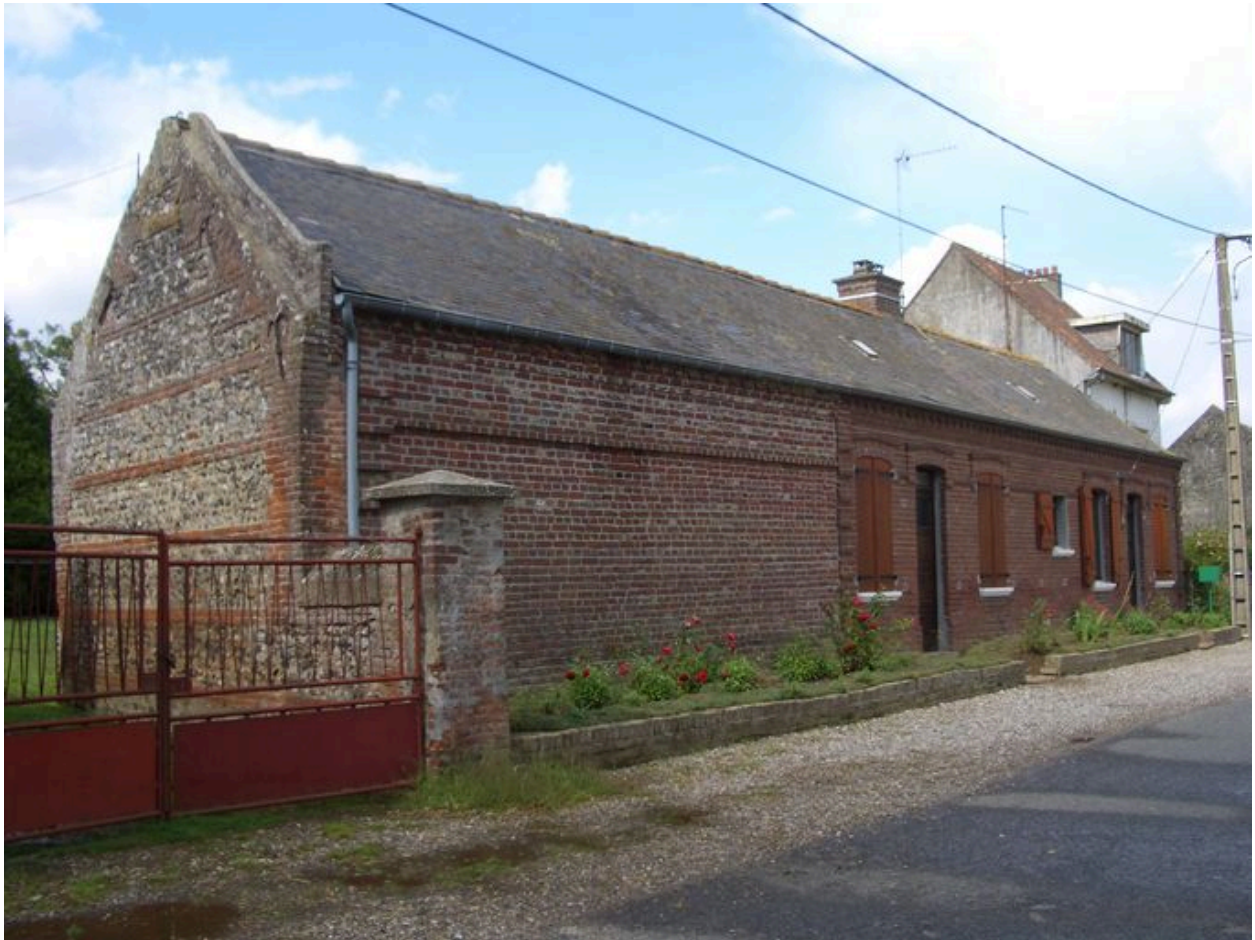
Vue du logis sur rue.
