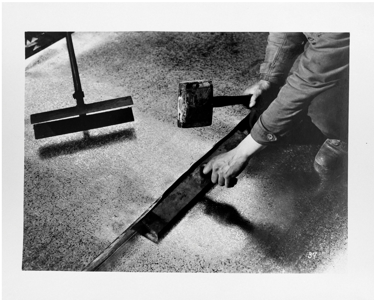
Atelier Rubafer, emboutissage de toitures : toiture plate sur plancher. Photographie ancienne, auteur inconnu, sans date (coll. part.).
