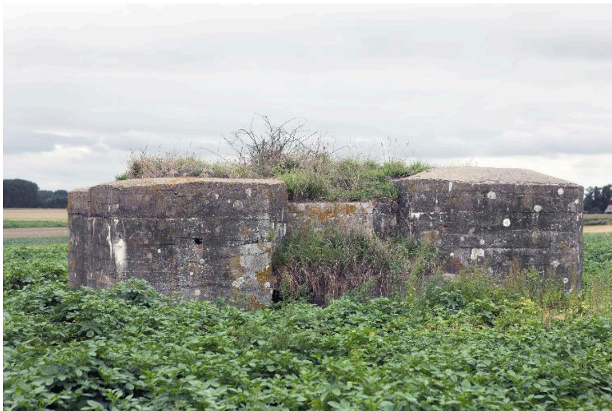
Élévation antérieure, vers l'ouest
