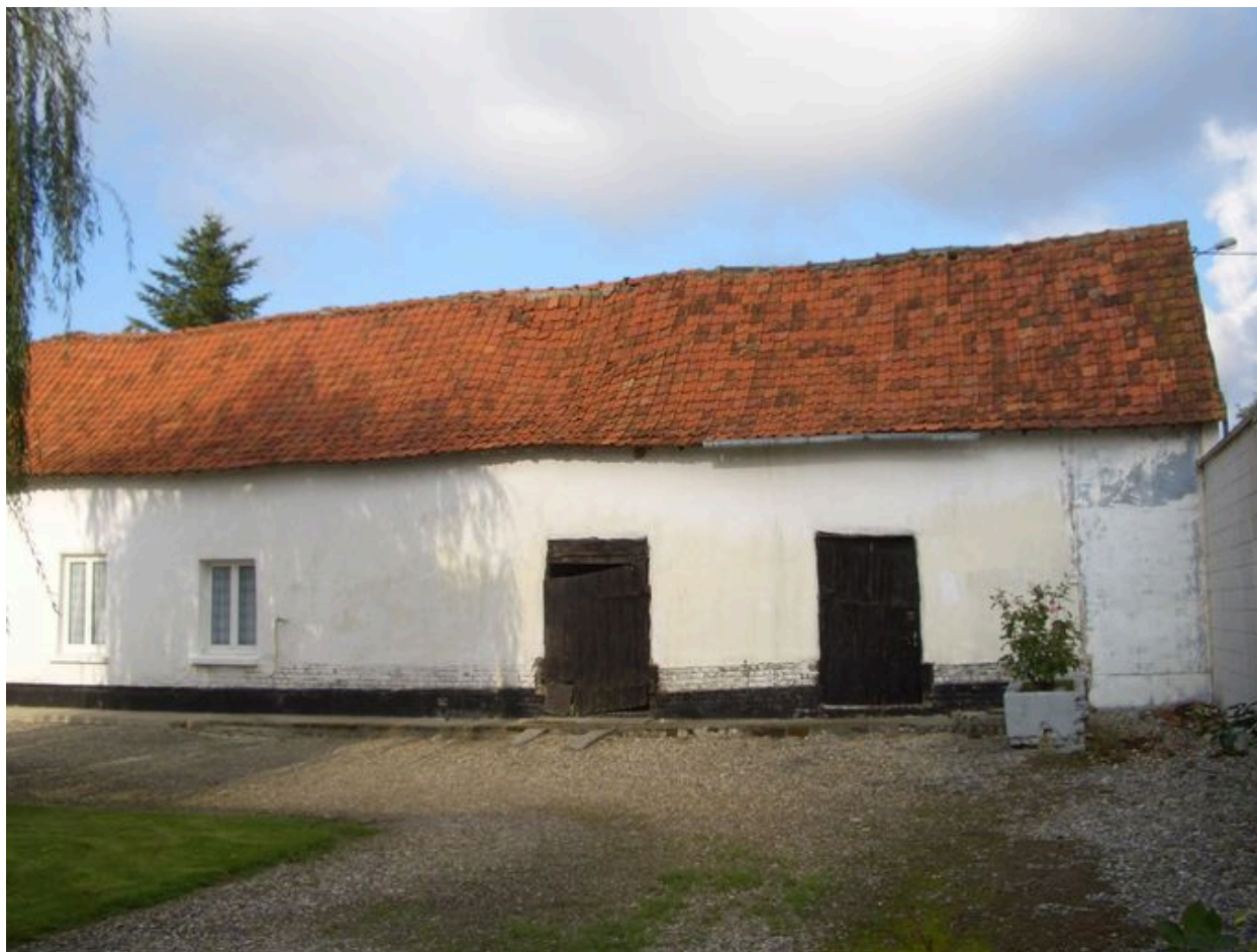
Vue de l'écurie dans le prolongement de le partie habitable.
