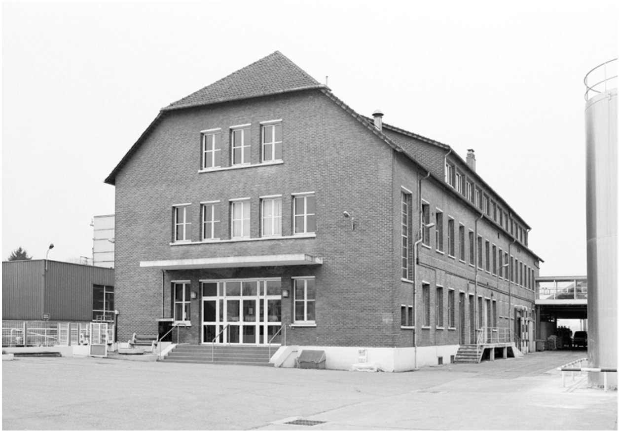
Vue générale nord-est du bâtiment social.
