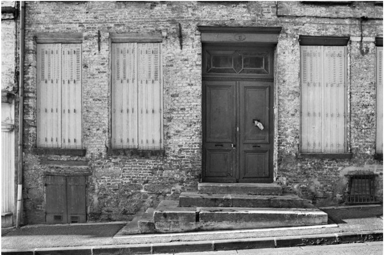
Détail du rez-de-chaussée.
