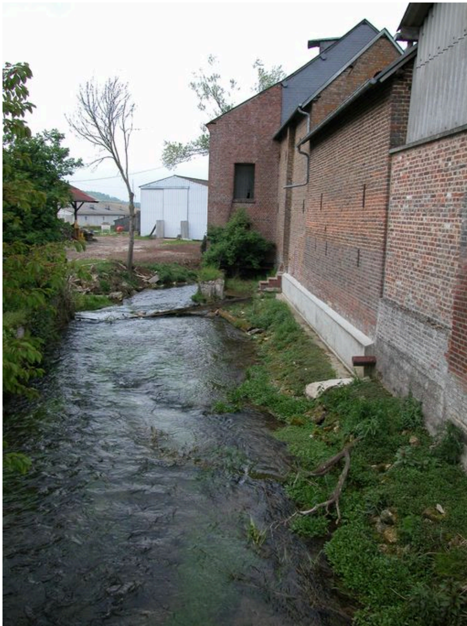
La rivière longeant les bâtiments de la minoterie, en amont de la chute.
