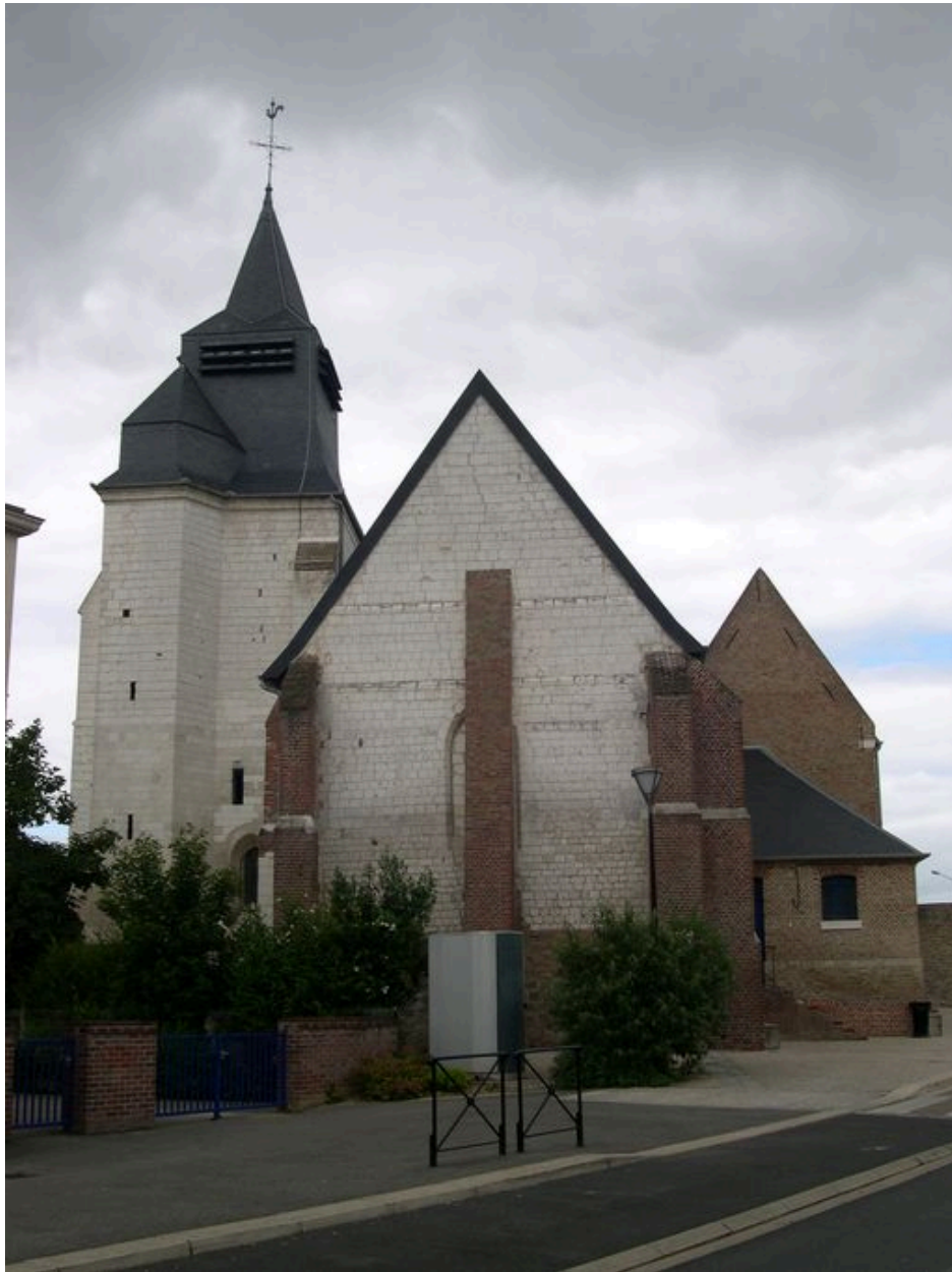
Vue générale depuis l'est.
