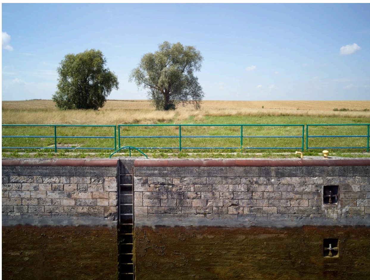
Site d'écluse n°7 de Graincourt-lès-Havrincourt.
