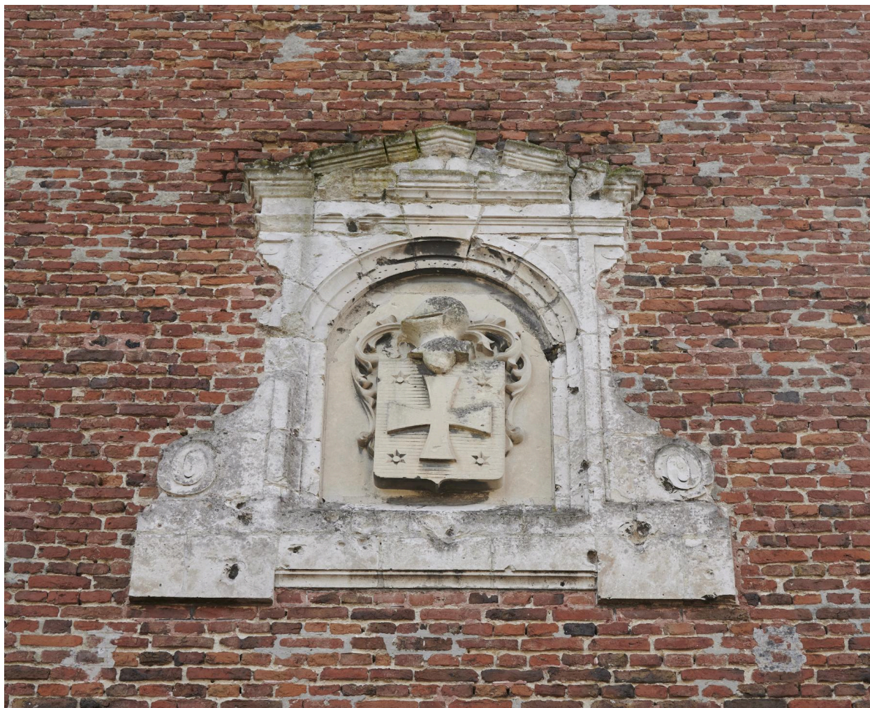
Détail du cartouche extérieur de la tour porche.
