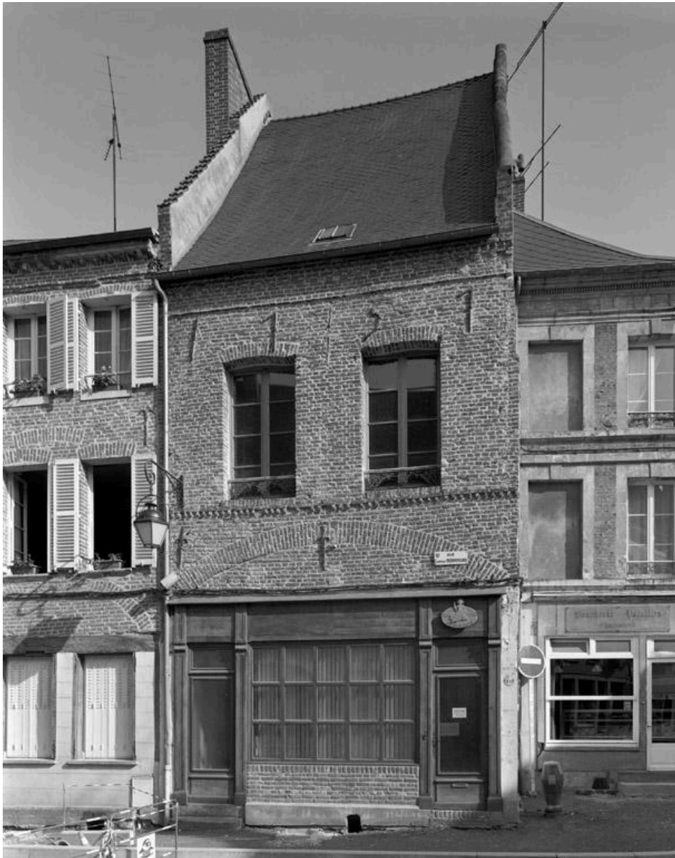
Vue de la façade sur rue.
