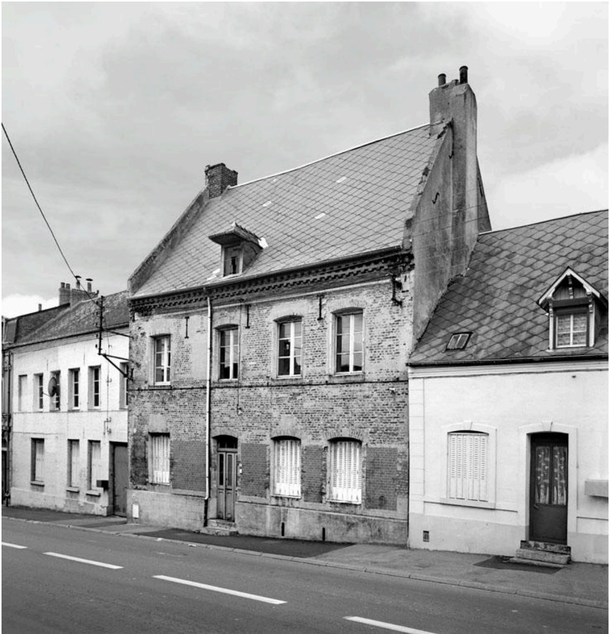
Vue de la façade sur rue.
