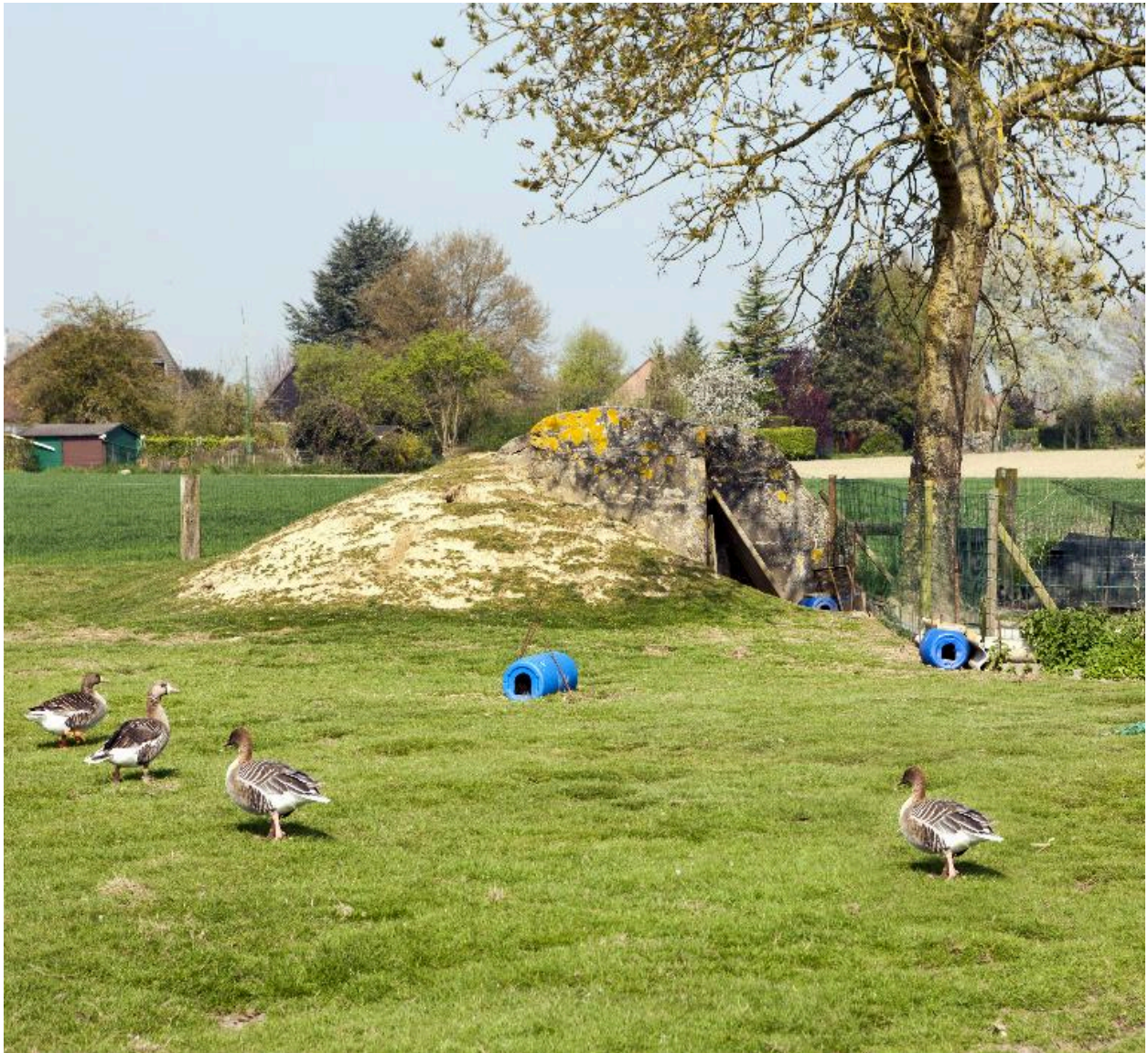
Casemate ouest, vers le nord-ouest
