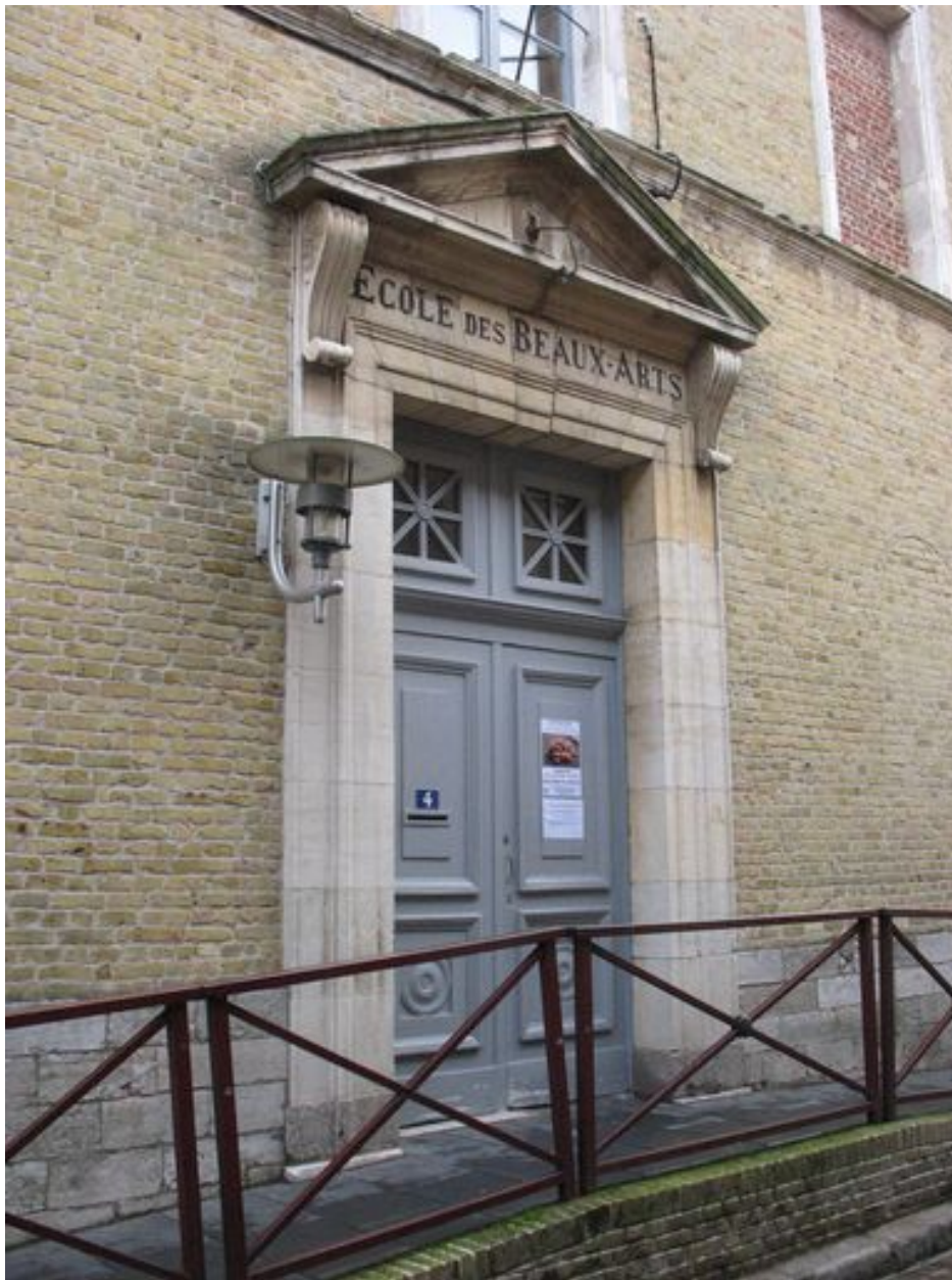
Façade sur rue : portail
