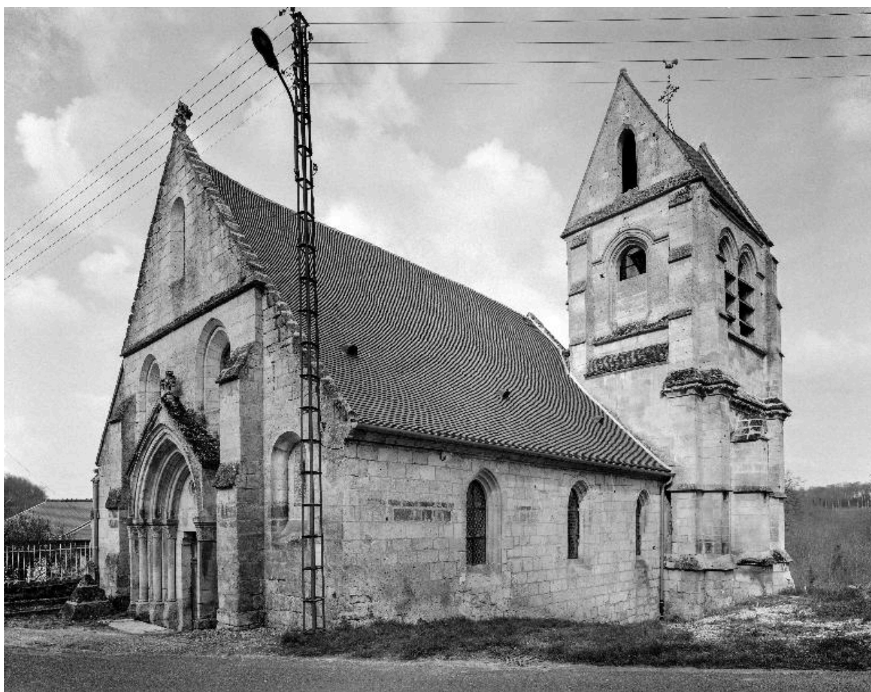
Vue générale sud-ouest de l'église.
