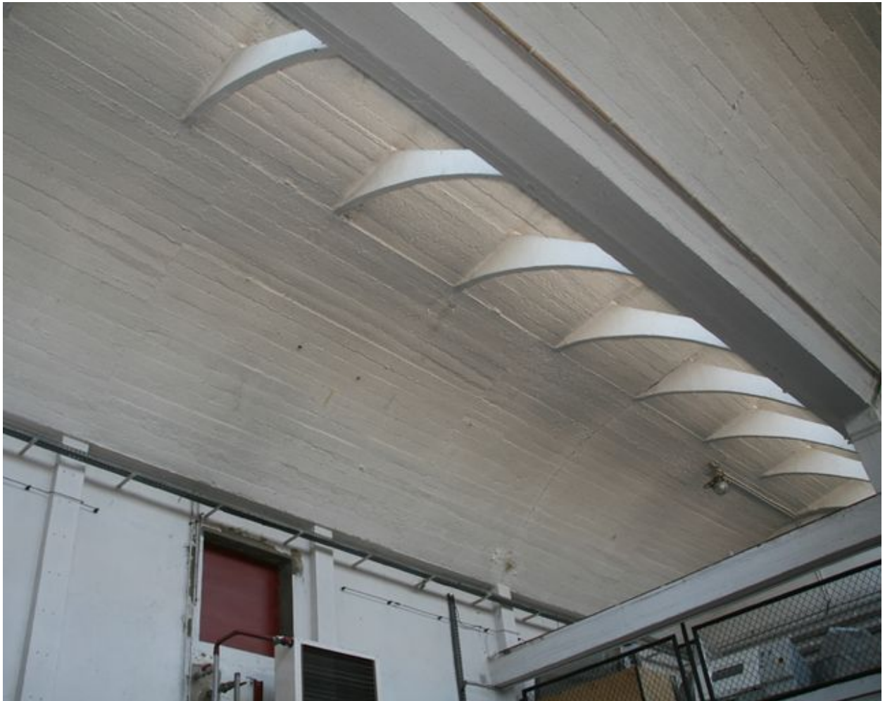
Détail de la structure des sheds paraboliques construits par Perret.
