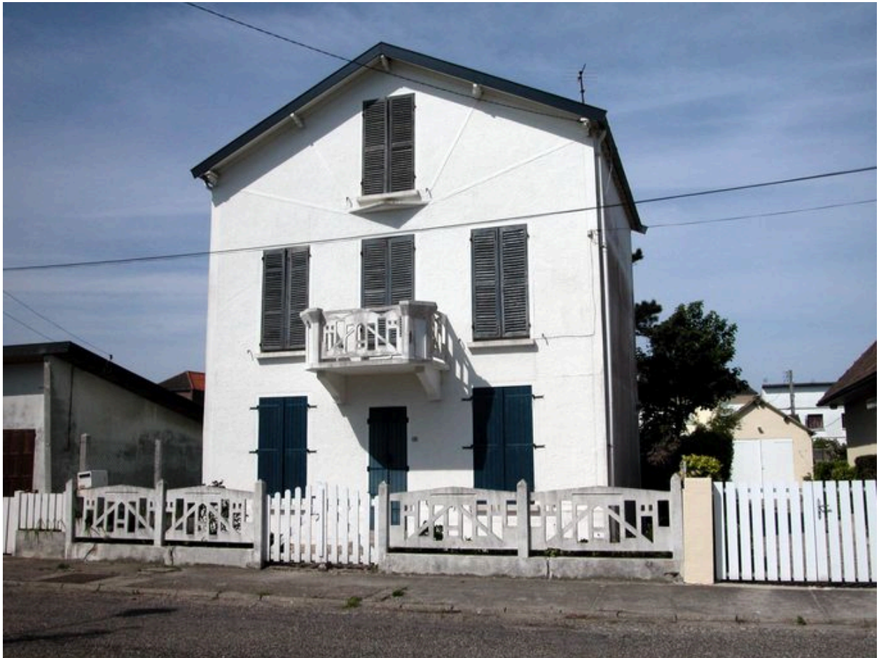
Clôture et balcons influencés par le style Art déco (63 rue Dujardin).
