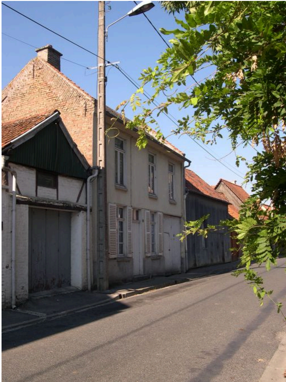
Maison, 7 et 9 rue des Bois.
