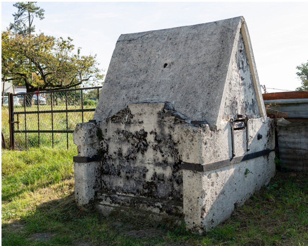
Ancien puits, en face du n°15 de la rue de Montididier, vue prise depuis l'ouest.
