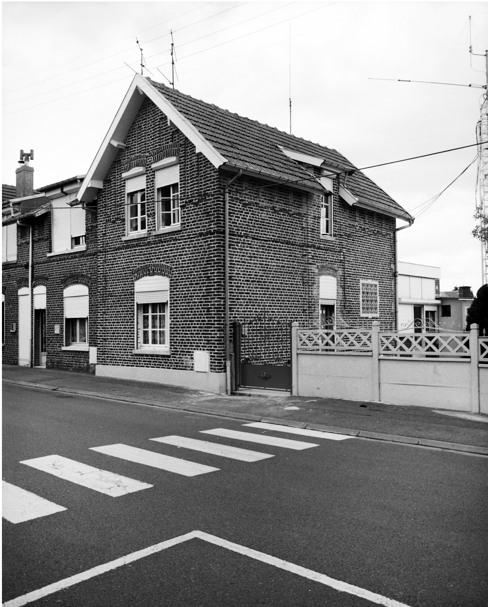
Vue générale de la maison faisant l'angle du module de six maisons au numéro 12, rue Gambetta.
