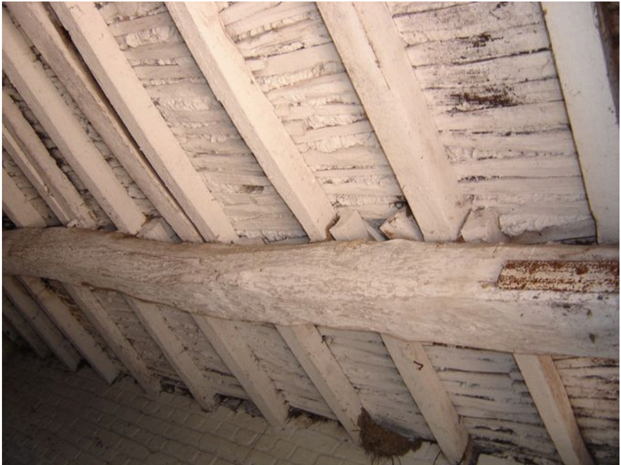
Vue du plafond d'une deuxième étable ici fait en torchis et non plus en plancher.
