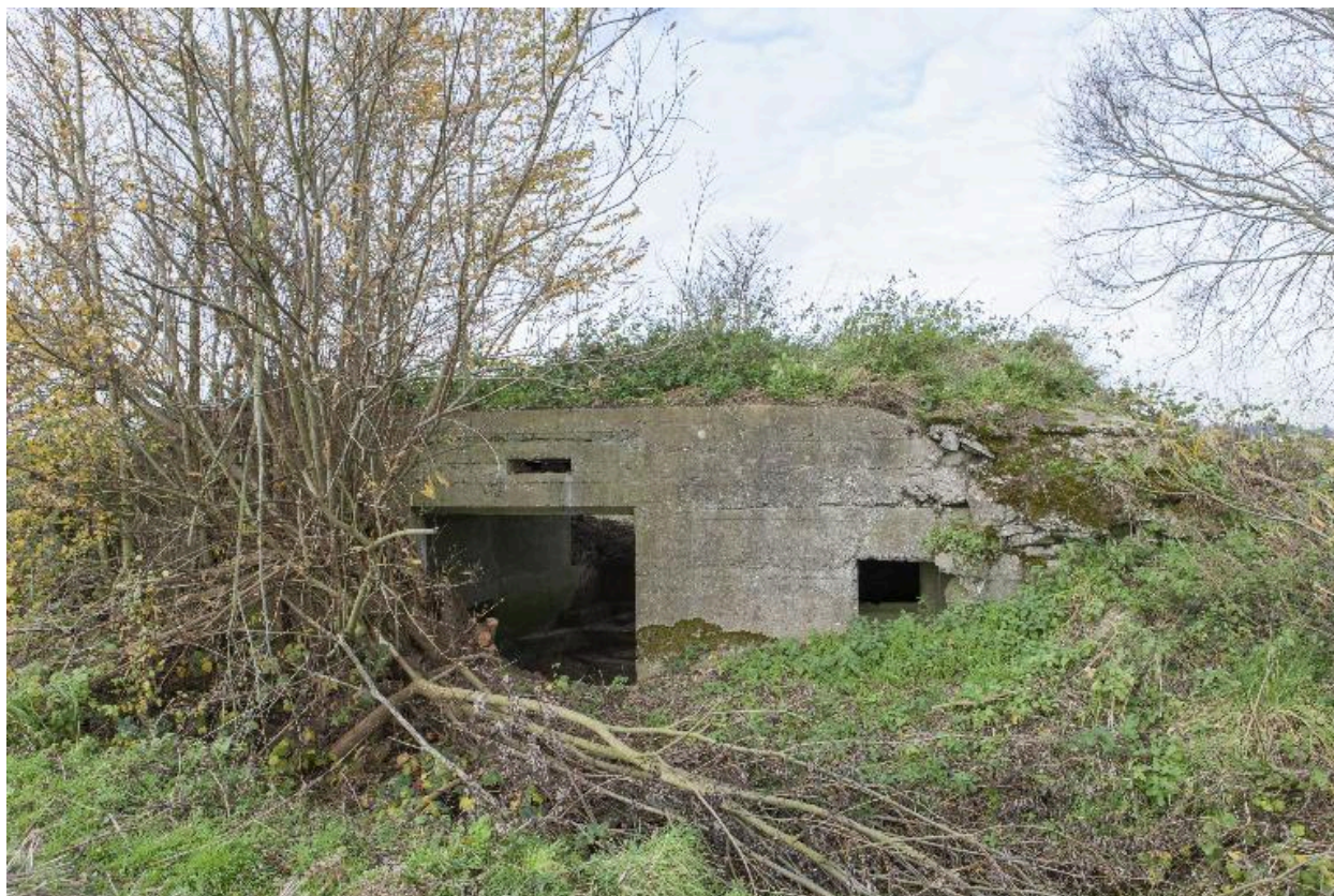
Élévation sud-est : entrée de la chambre de tir et abri à personnel, à droite
