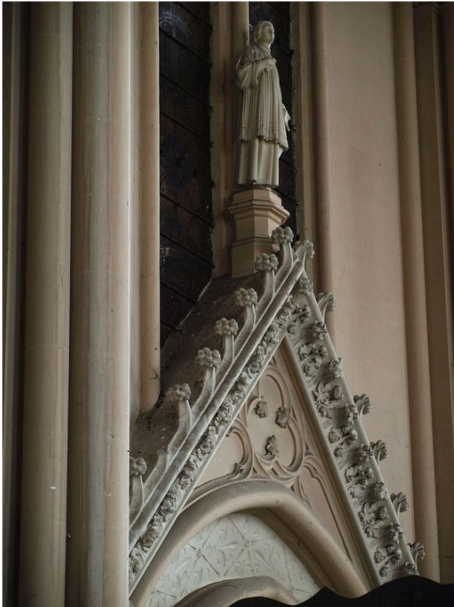
Vue générale de situation
