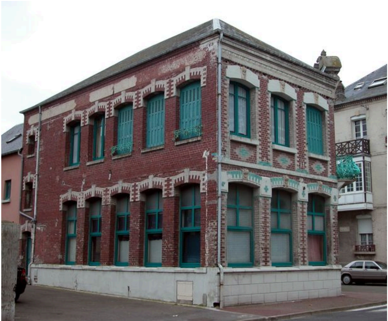
Élévation postérieure sur la cour.
