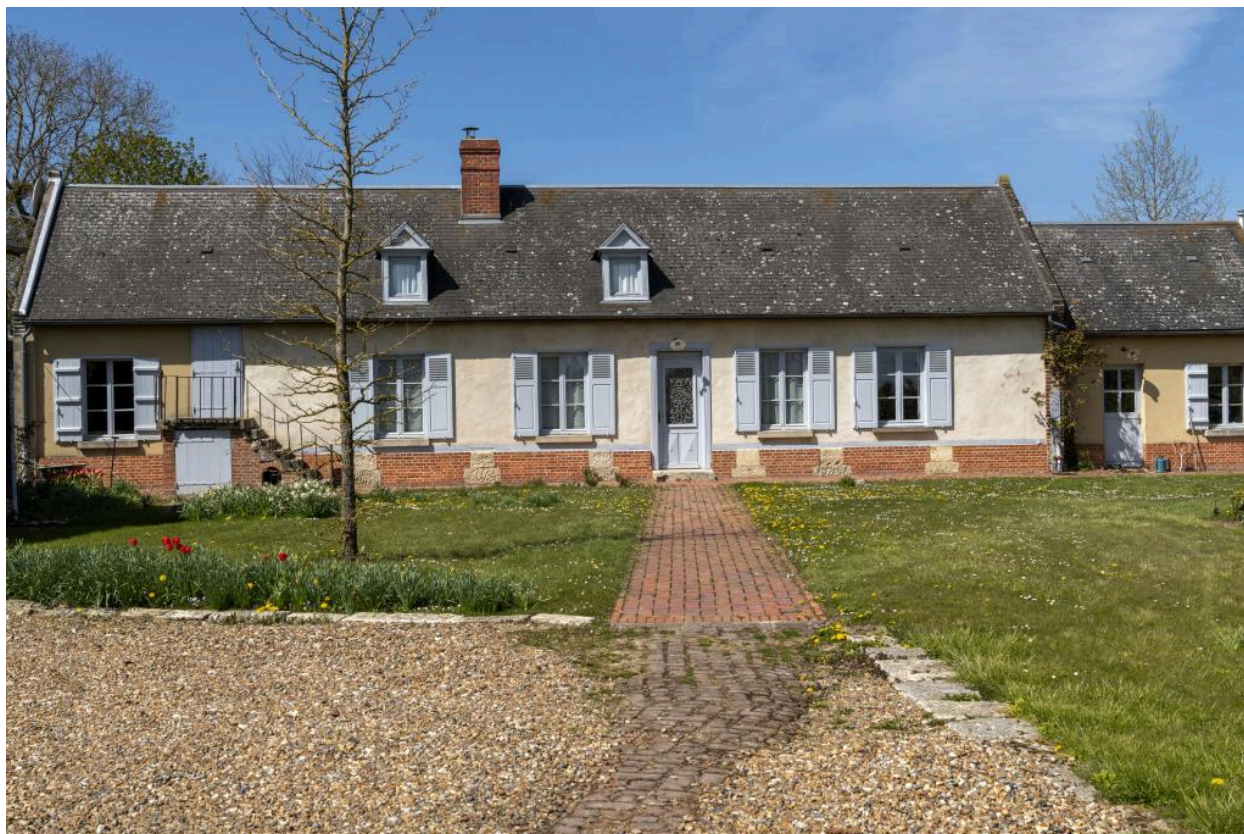
Logis, n°54 rue Principale, vue depuis l'est.
