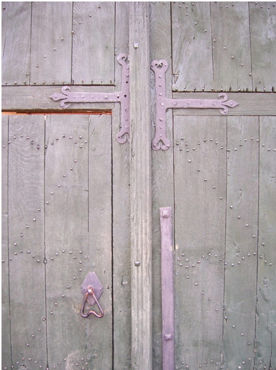
Ferme, 190 rue du Général-Leclerc, détail de la porte charretière.
