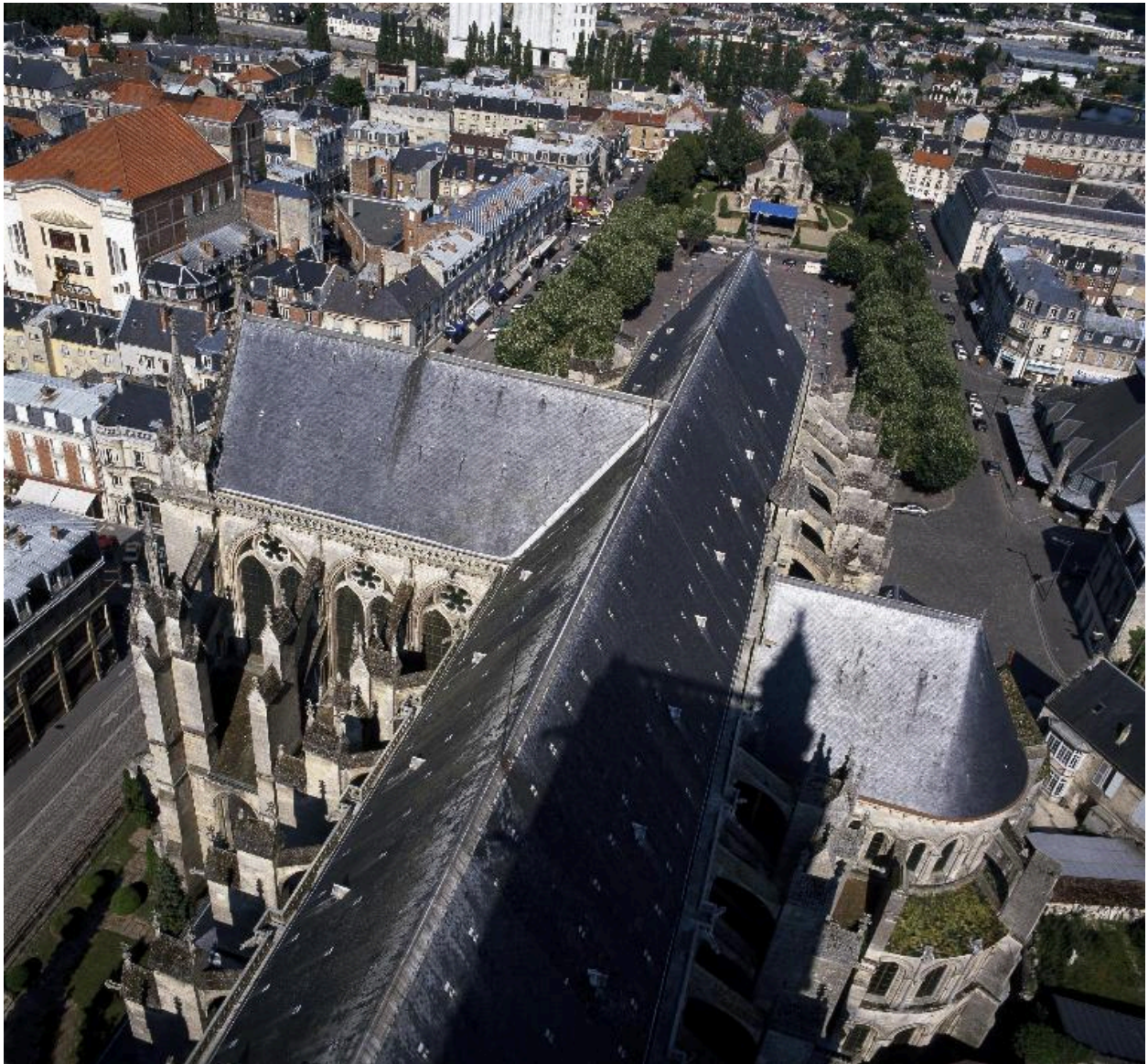
Vue des toits de la cathédrale, depuis la tour.
