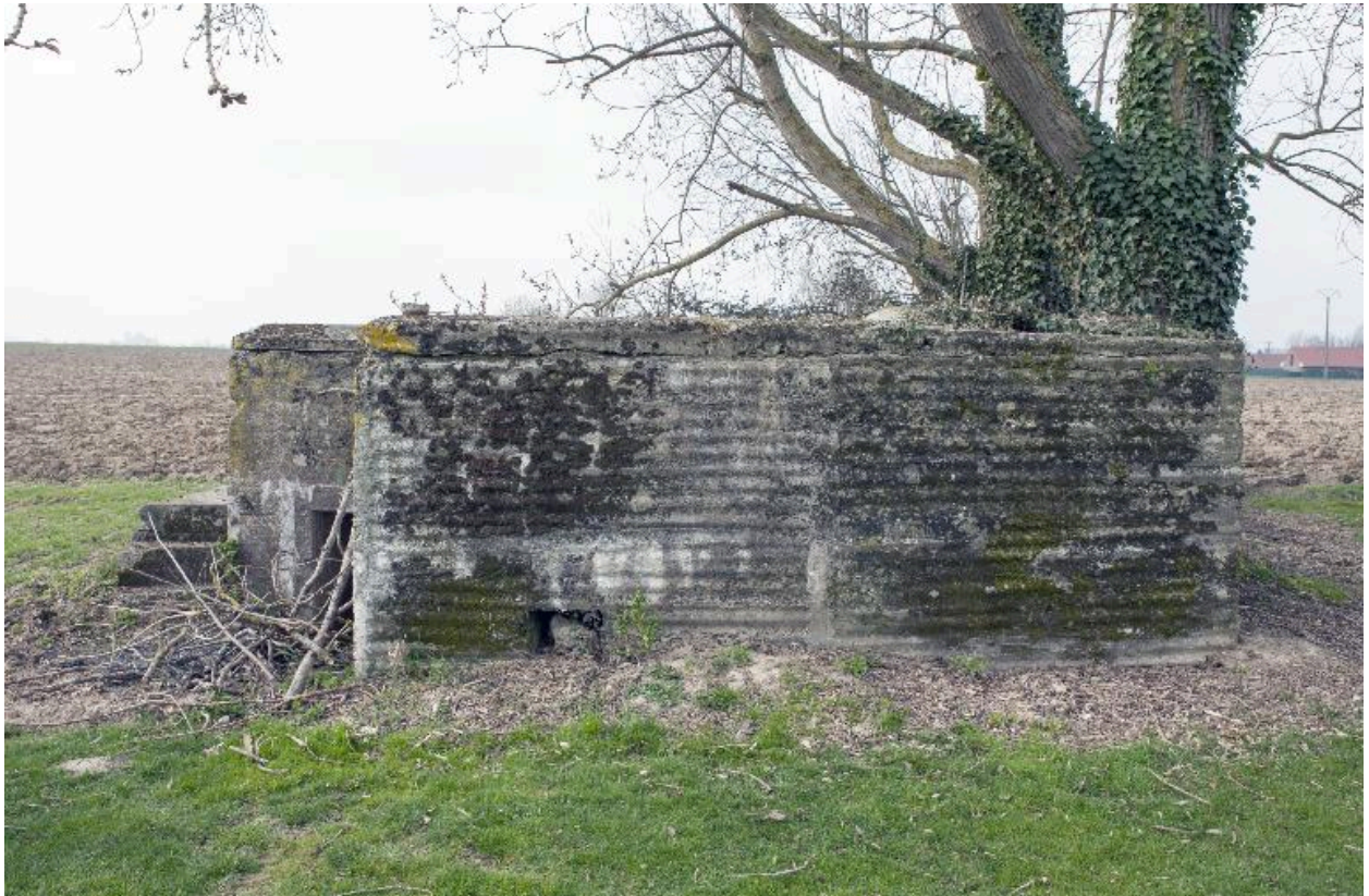
Vue latérale de l'édifice, vers le sud-ouest.
