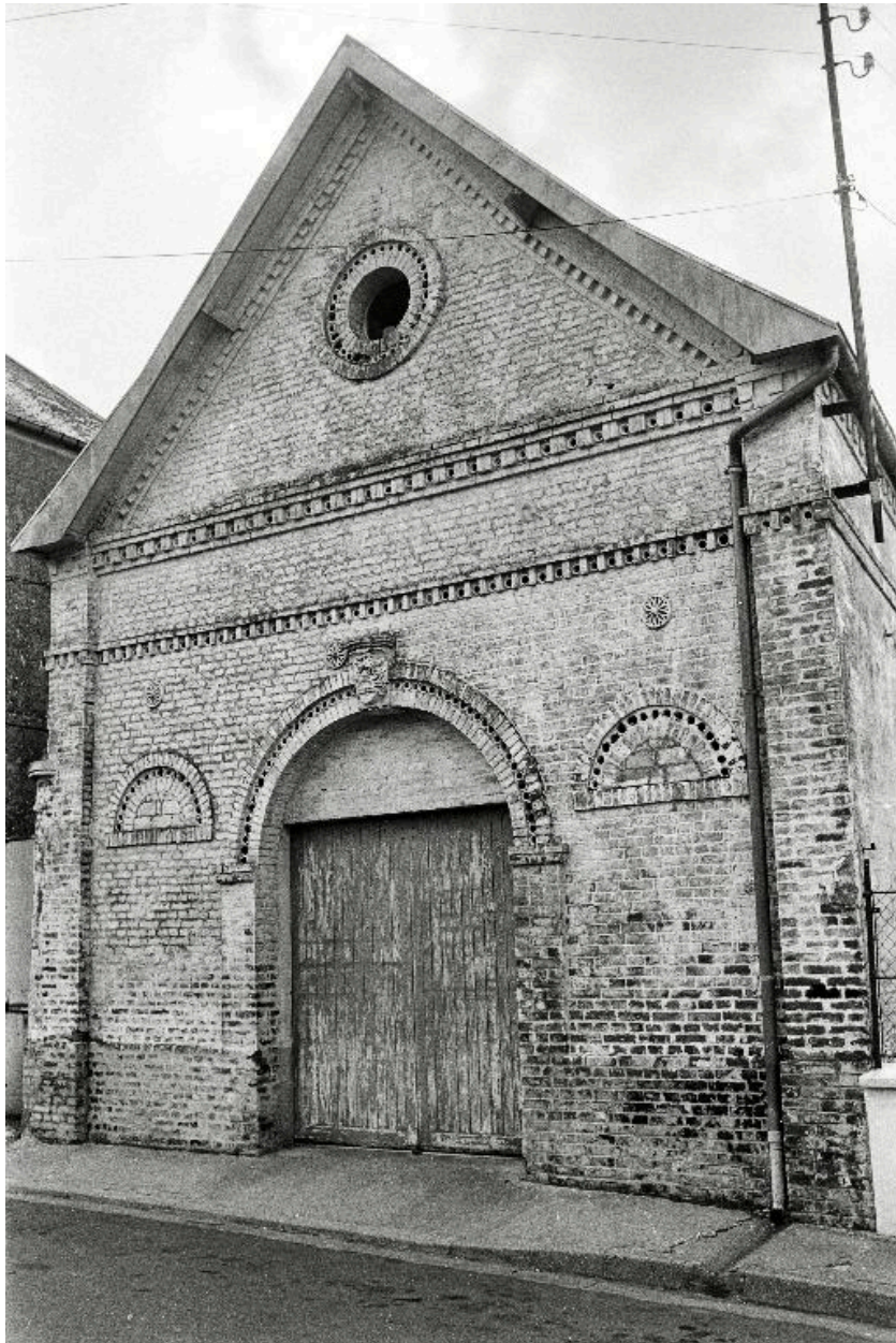
Vue du pignon de l'entrepôt de l'ancien marchand de vins, en 1990.
