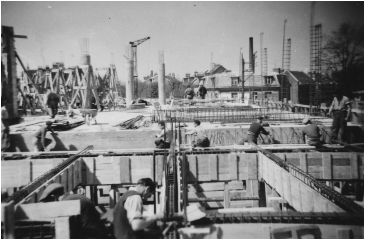
Chantier de construction des ateliers, 1948 (IFA).
