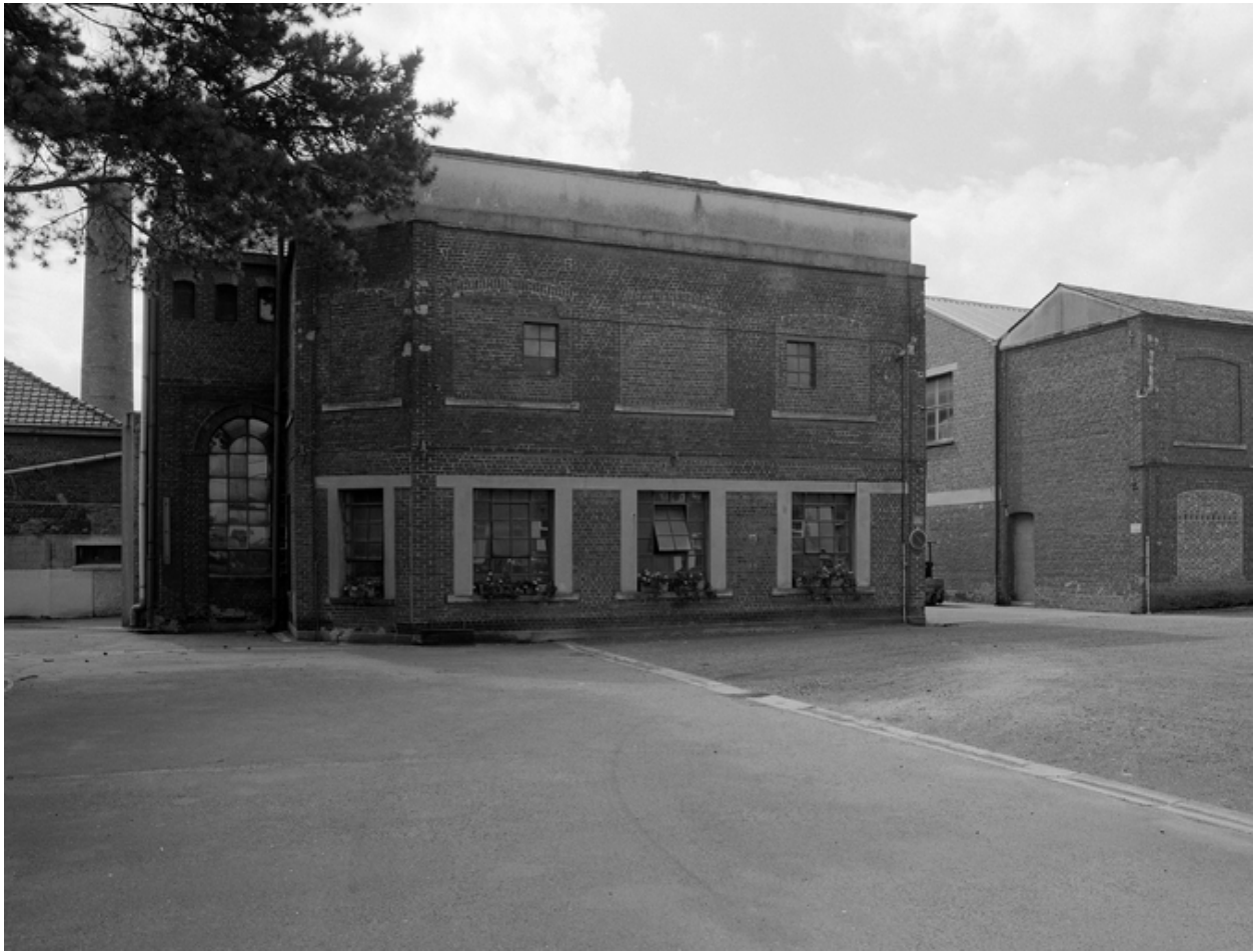
Vue intérieure de la cour, travée originelle des bâtiments industriels.
