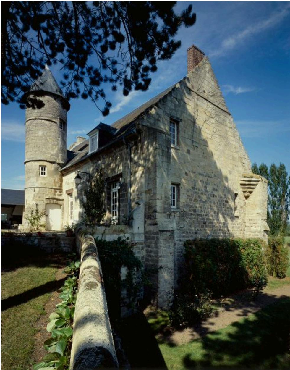
Logis. Pignon sud-est.
