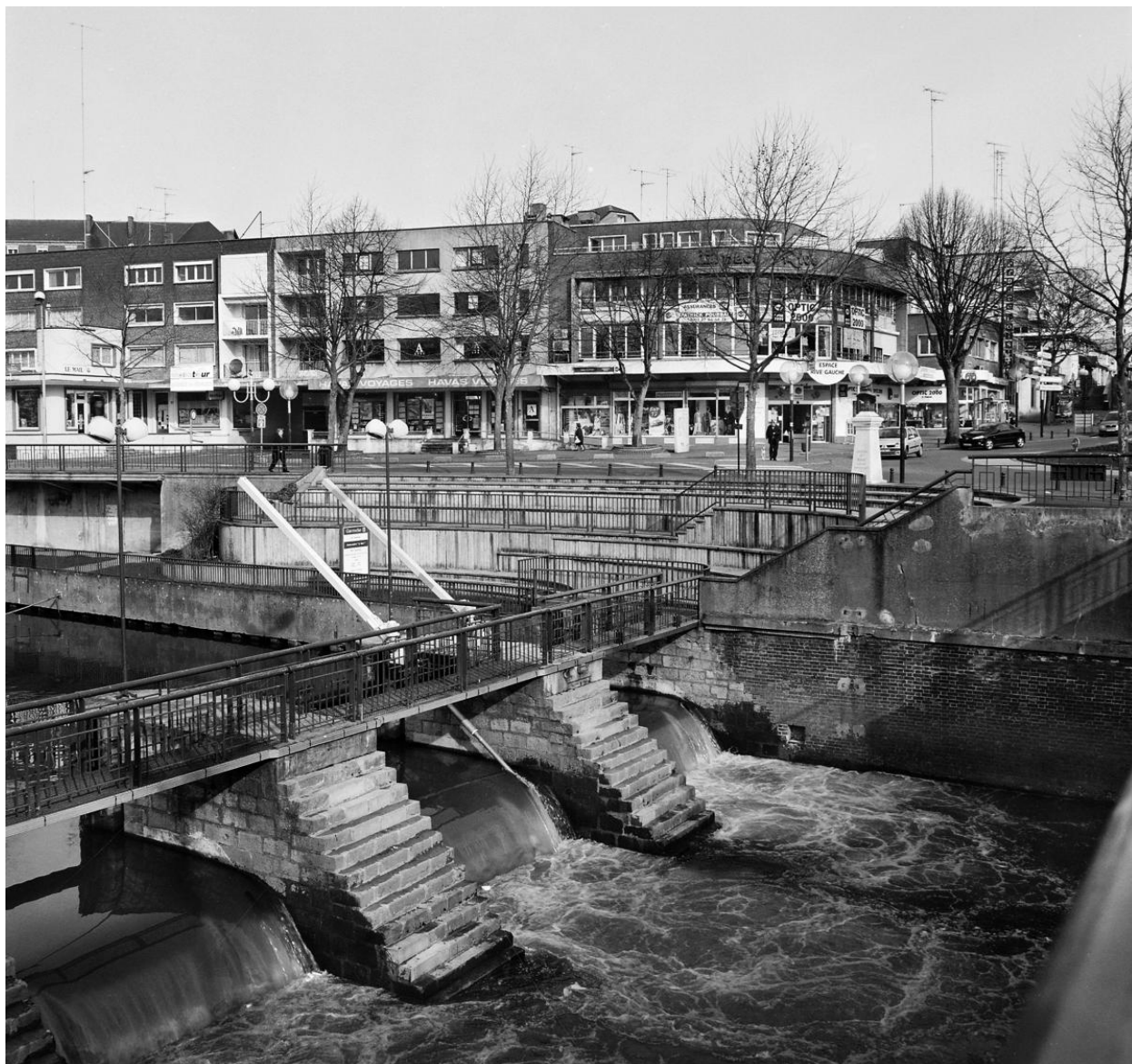
Vue générale de l'écluse de Maubeuge et aménagement du quai.
