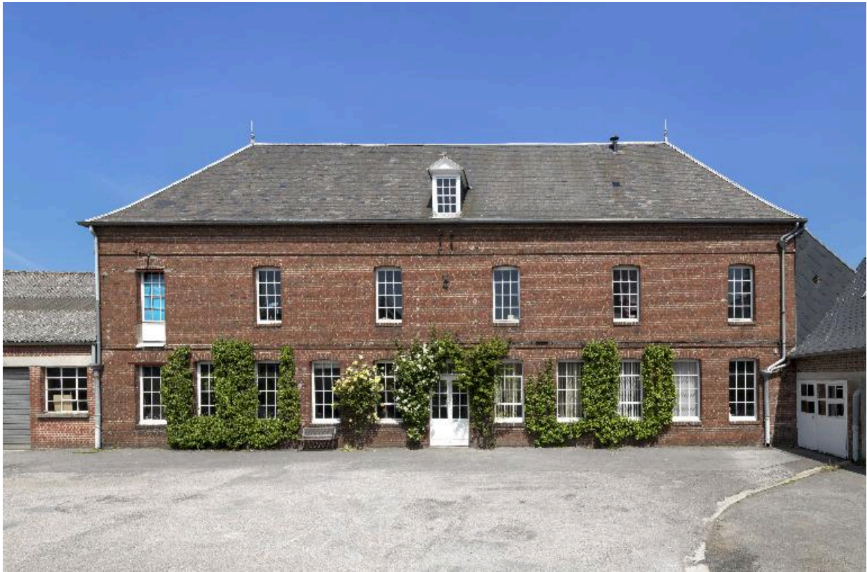
Vue du bâtiment de fabrication principal.
