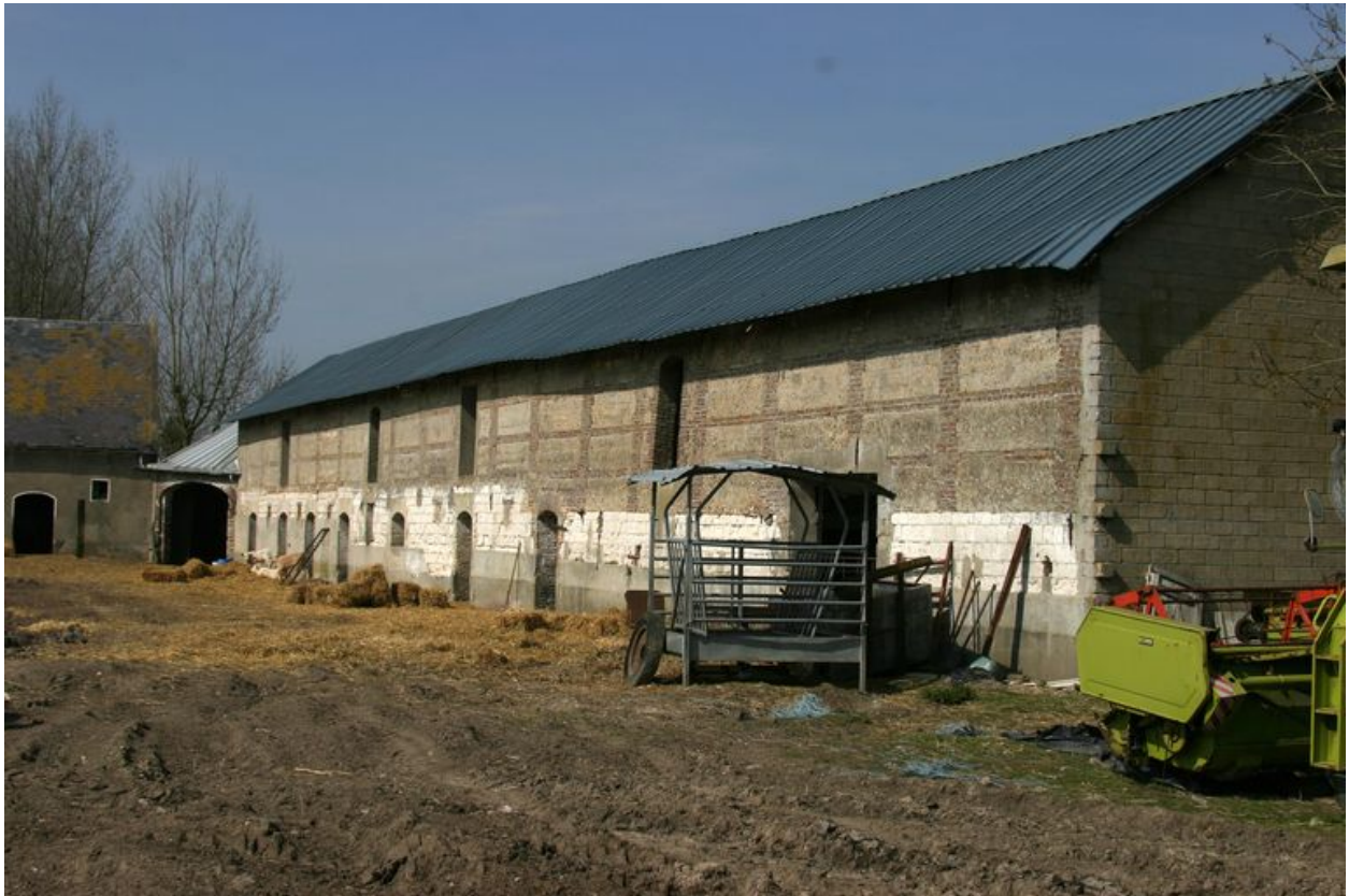
Vue sur l'étable nord depuis l'entrée principale à l'est.
